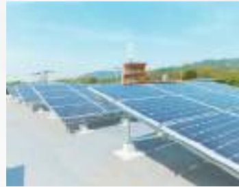
49.5kW 広島県福山市
