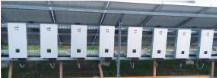
49.5kW 福岡県大川市
