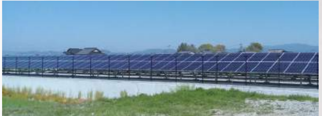
49.5kW 福岡県大川市
