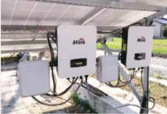
49.5kW 福岡県大川市
