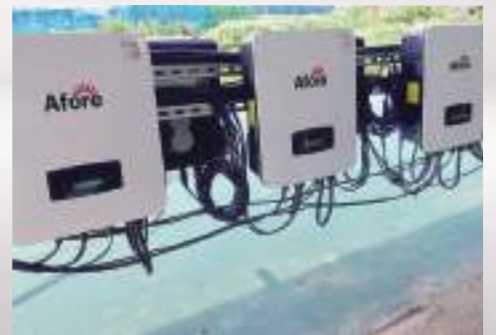
49.5kW 福岡県大川市
