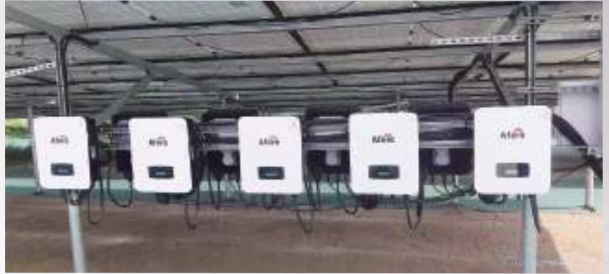
49.5kW 福岡県大川市
