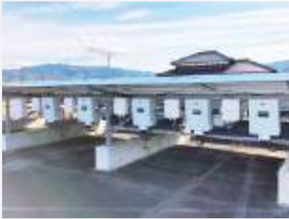
49.5kW 広島県福山市
